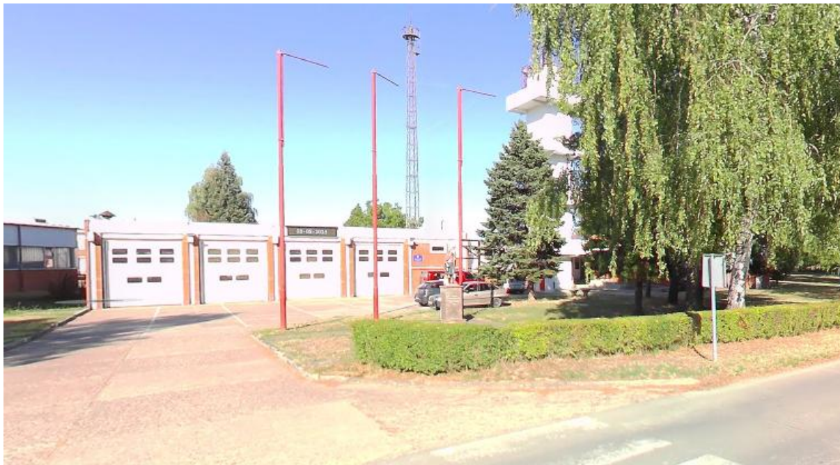
SLIKA 14: ZGRADA DVD-A BELIŠĆE
