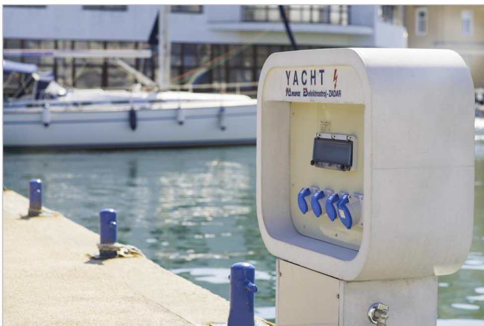
Slika 29 - PRIKLJUČNI ENERGETSKI I VODOOPSKRBNI ORMARIĆ
